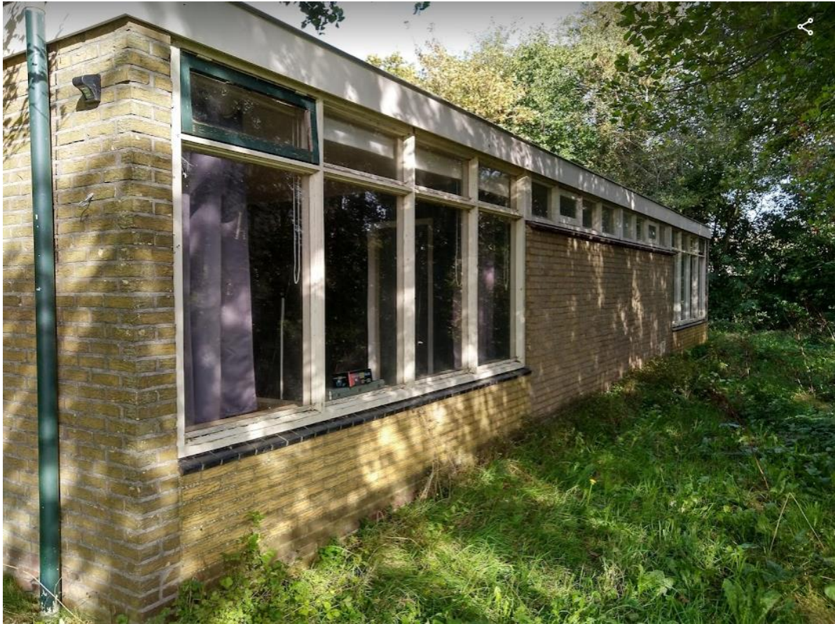
Achterzijde gebouw met de twee voormalig gecreëerde woon-units
